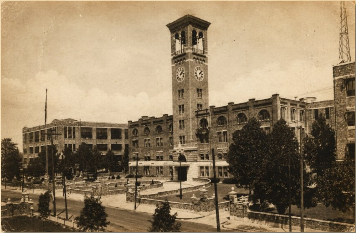
Abb.: Die alte USPCC-Fabrik in Norwood, Ohio war ein markanter Backstein-Industriebau mit Uhrturm und wurde über Jahrzehnte mit Bicycle verbunden. Die ältesten Teile des Komplexes stammten aus der Zeit um 1903; der Standort wurde später aufgegeben und 2020 abgerissen.
