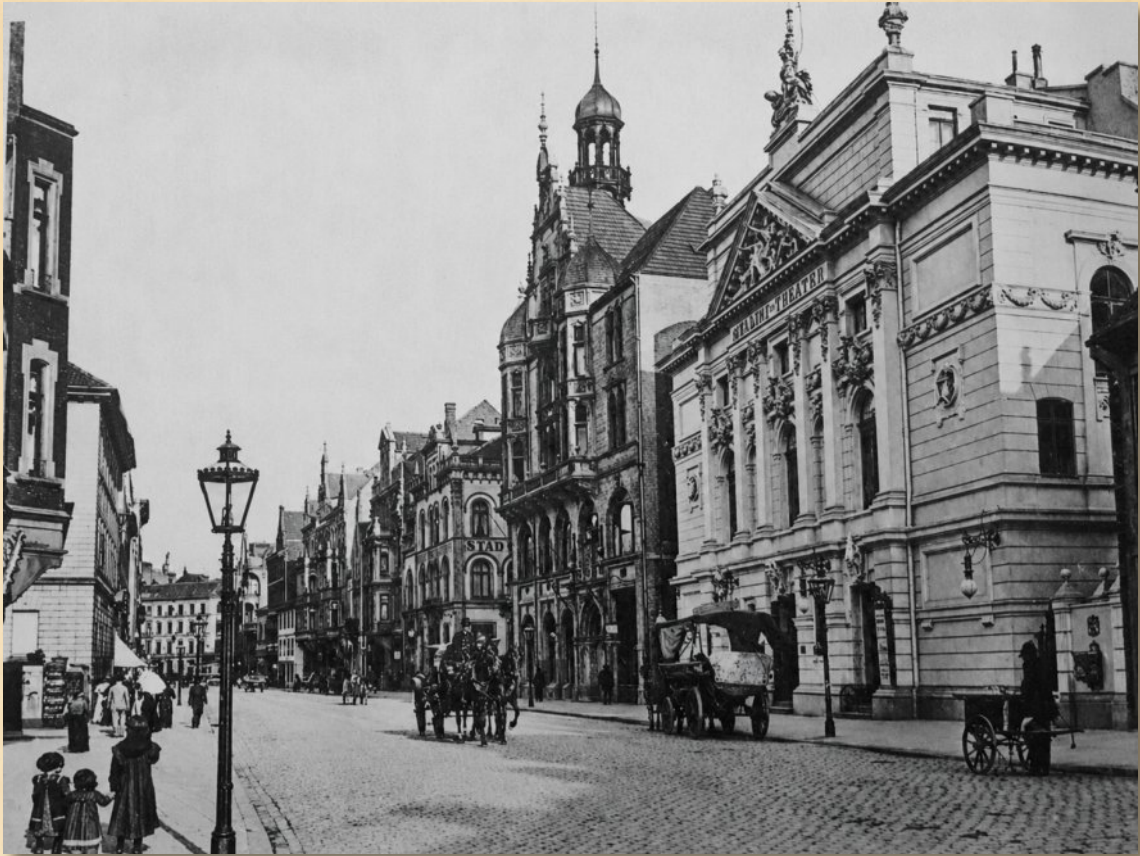
Abb.: Das Mellini-Theater befand sich in der Artilleristraße in Hannover. Hier eine Aufnahme der Straße aus dem Jahr 1900. Das Theater wurde im Jahr 1954 abgerissen.
